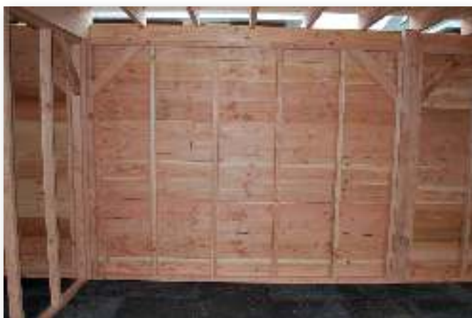
DETAIL: WANDEN OP REGELWERK
