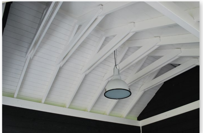
3 | BINNENAANZICHT ONDERZIJDE DAK
