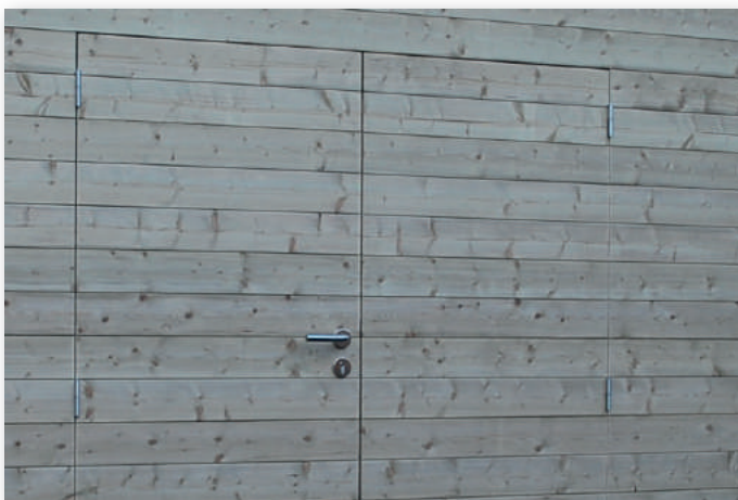
48 | DETAIL WANDEN VUREN (VLAK PROFIEL)
