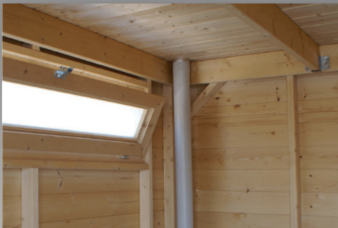
42 | DETAIL AFVOER VIA BINNENZIJDE
