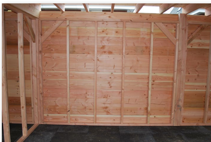
DETAIL: WANDEN OP REGELWERK
